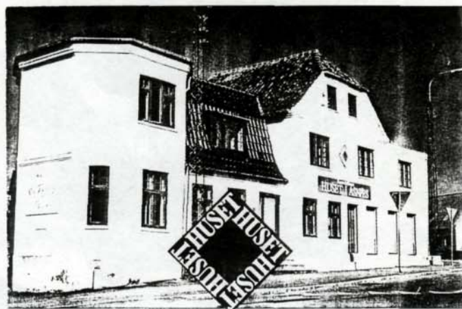
"Huset i Asnæs"
