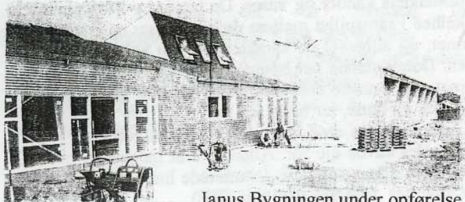
Janus Bygningen under opførelse.
