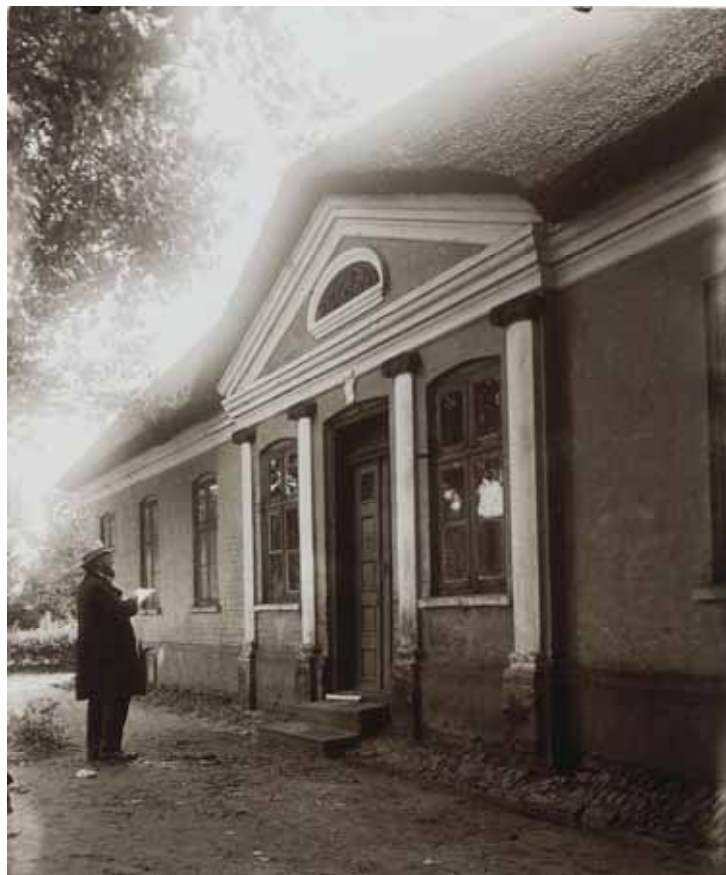
Hos nogle af P. V. Jensen-Klints efterkommere viste der sig et fotografi fra 1910'erne, hvor han er på opmåling ved Det gule Hus i Andst.
